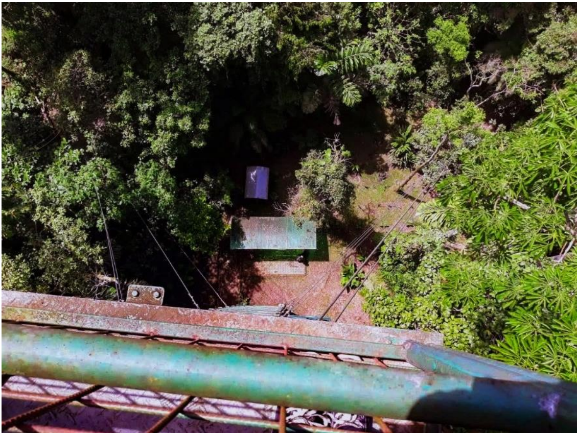
Ilustración 15-1: Vista desde la torre de 36m.
