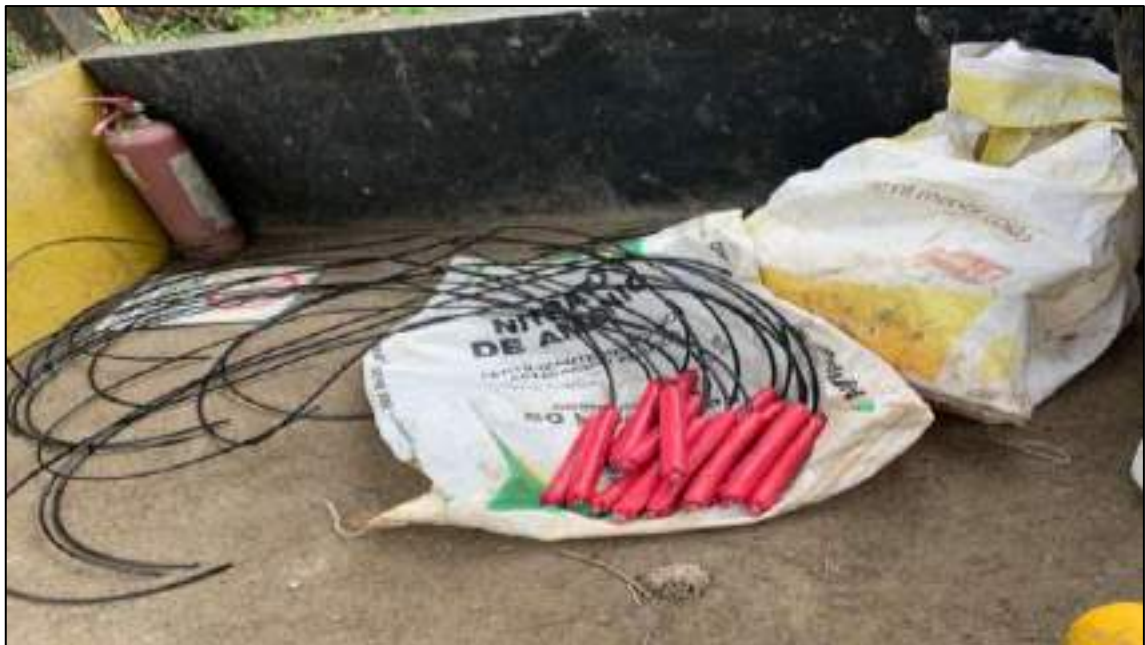
Ilustración 4-3: Preparación de cargas explosivas de Emulnor 3000 con detonante N°8 y 1.30 m de mecha de seguridad.
