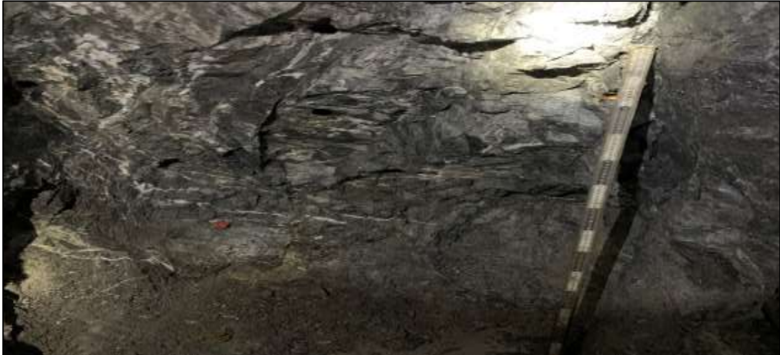
Ilustración 5-3: Macizo rocoso presente en el frente de explotación
