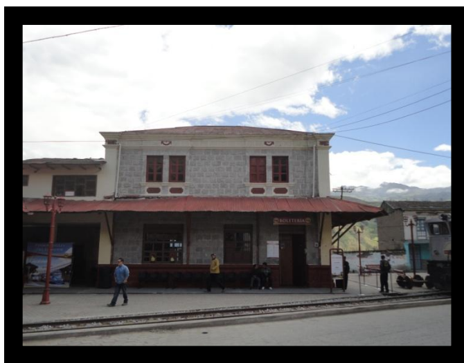
Foto N° 44: Estación del Ferrocarril de Alausí
