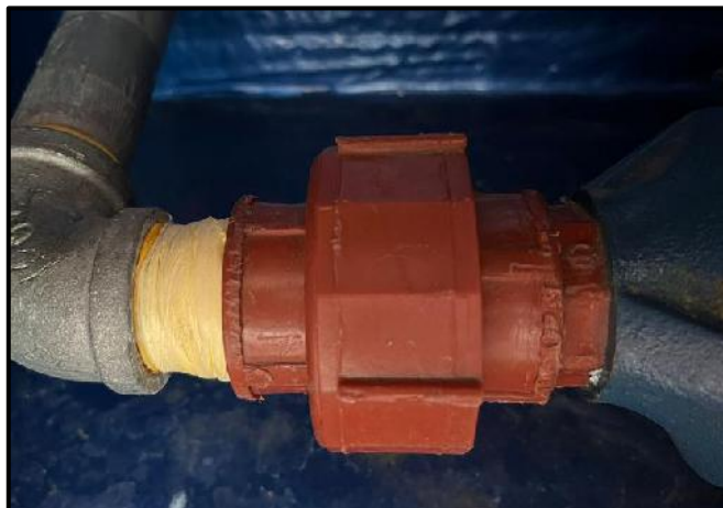
Ilustración 74-4: Empaques en las uniones nuevos.
