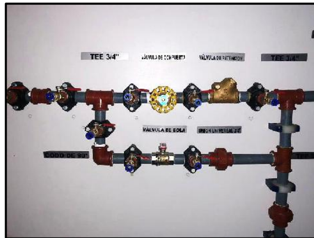
Ilustración 81-4: Acoples rápidos en cada válvula.
