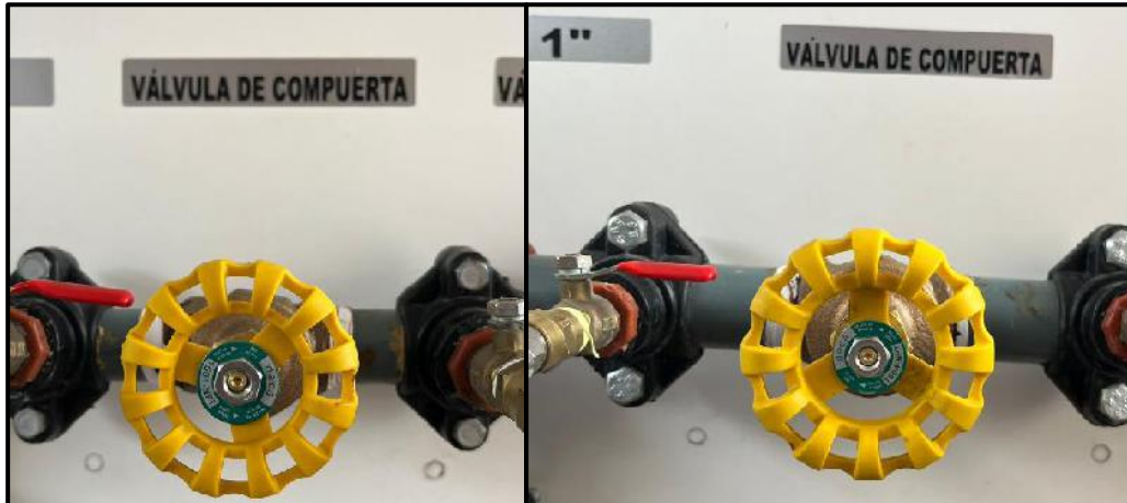
Ilustración 75-4: Válvulas de compuerta nuevas y rotadas 90^\circ .
