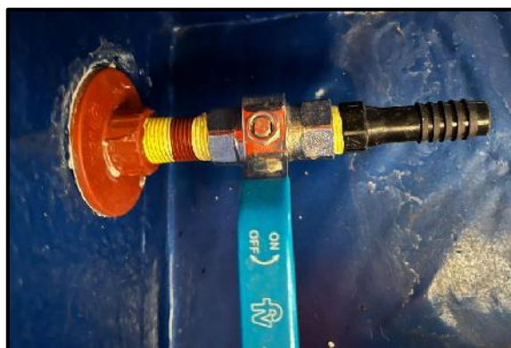
Ilustración 70-4: Acople de tanque y válvula de bola
