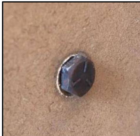
Ilustración 54-3: Desgaste posterior del tablero
