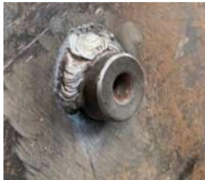
**Ilustración 32-3:** Soldadura de protuberancia para impacto
