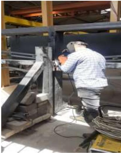
**Ilustración 26-3:** Desmontaje de placa base
