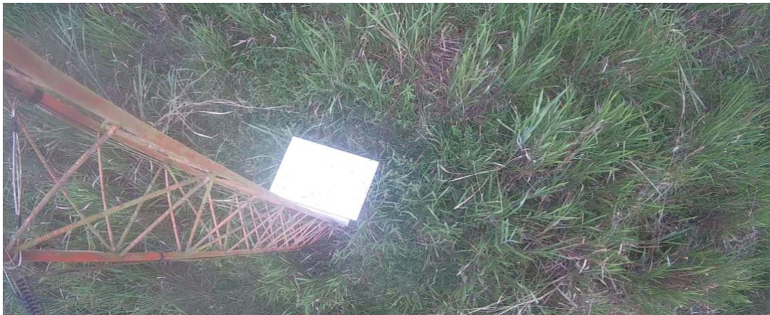
Figura 23-4: Cámara de Torre (Erica Padilla, 2022)
