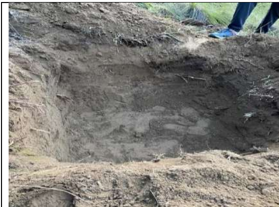
1. Excavaciones de calicata 1
