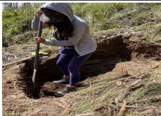
5. Excavaciones de calicata 5
