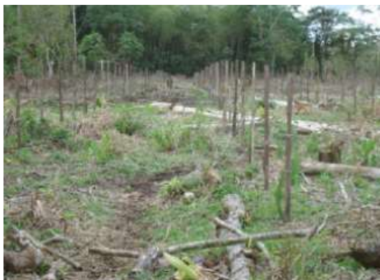
Figura 2-3. Proceso de preparación del terreno
