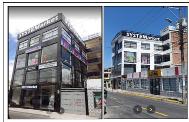
Figura 4-3: Edificio Fuente: Portal web “SYSTEMarket”
