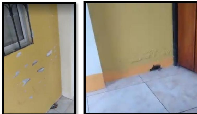
**Figura 2-1:** Indicios de fugas y humedad
