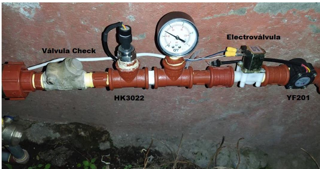
**Figura 2-4:** Instalación de los sensores y electroválvula
