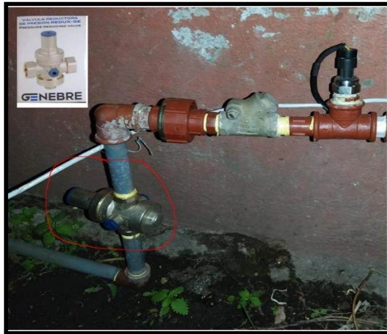
**Figura 6-4:** Instalación de manorreductor en la toma principal
