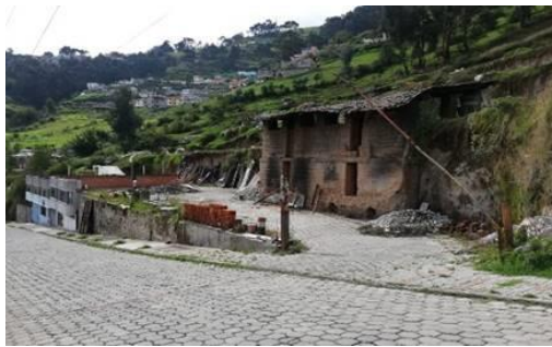
Fotografía 2: Construcción de ladrillos de forma tradicional
