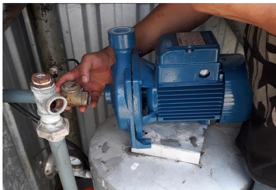
Figura 14-3: Instalación de la bomba centrífuga
