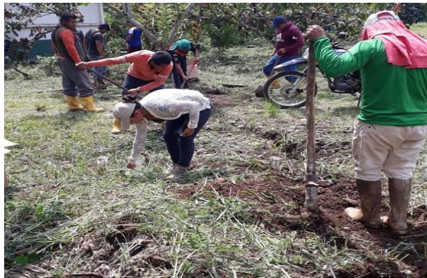
Figura 9-3: Excavación para el tendido eléctrico
