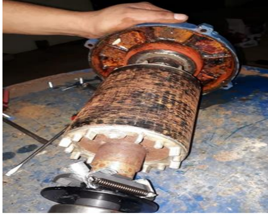
Figura 12-3: Desmontaje del motor del mezclador
