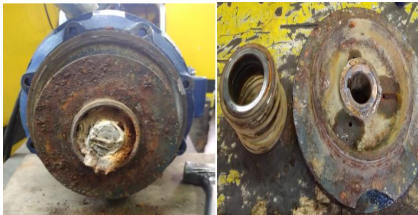
Figura 15-3: Desmontaje e inspección del impulsor y sello mecánico
