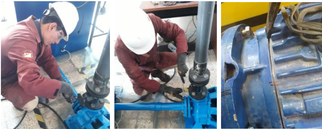
Figura 14-3: Proceso de desmontaje de las líneas de succión y descarga
