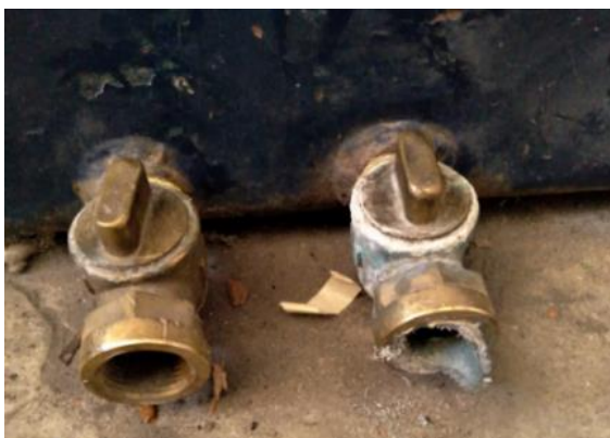
Figura 4-3: Válvulas de Drenaje
