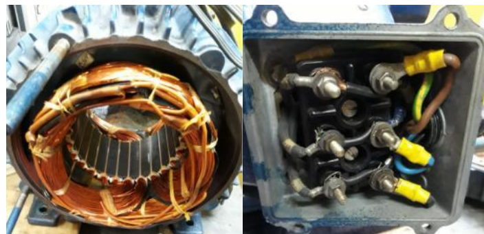
Figura 18-3: Limpieza e inspección del circuito eléctrico del motor
