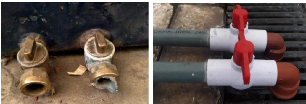
Figura 6-4: Comparación del estado de las válvulas de descarga
