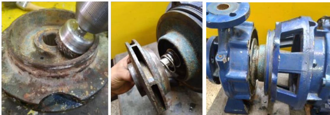
Figura 20-3: Limpieza y montaje de la bomba centrífuga
