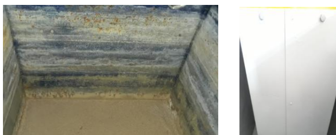
Figura 2-4: Comparación del estado del túnel de captación de agua
