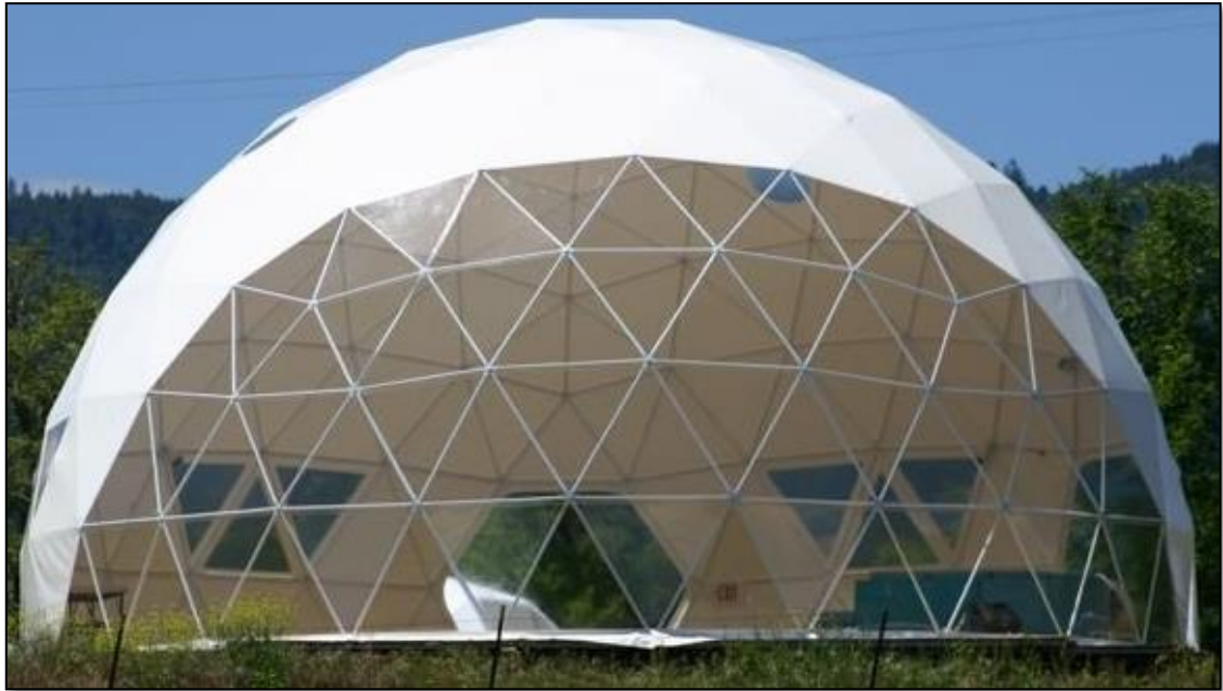
Figura 18 - 4. Fachada principal de geo domo matrimonial y familiar
