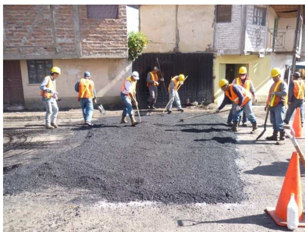
Figura 2.40. Tendido de Asfalto.
