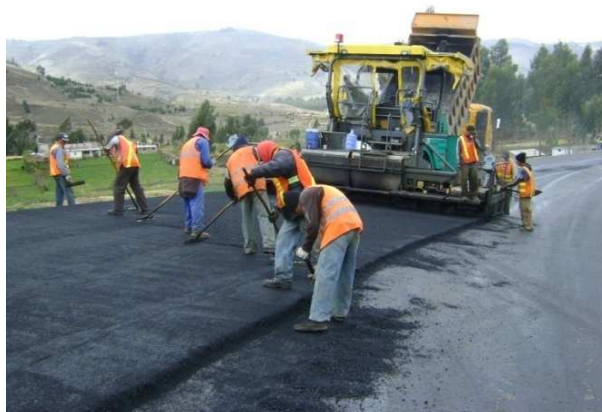
Figura 2.46. Asfalto en vía.
