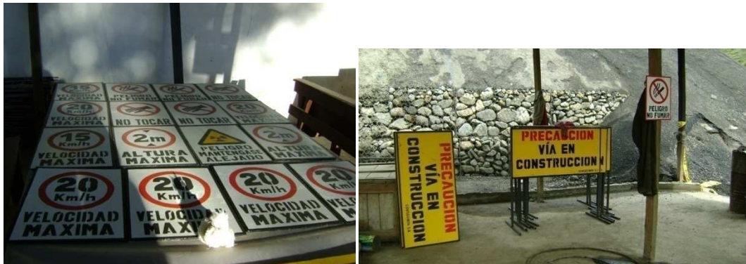
Figura 4.69. Construcción de letreros.
