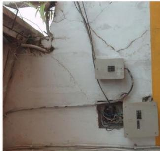
**Figura 45.** Cajetines sin protección ni señalización
