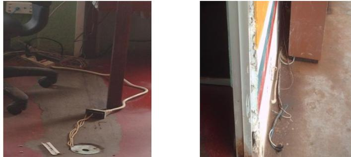
**Figura 44.** Instalaciones eléctricas sin canalización
