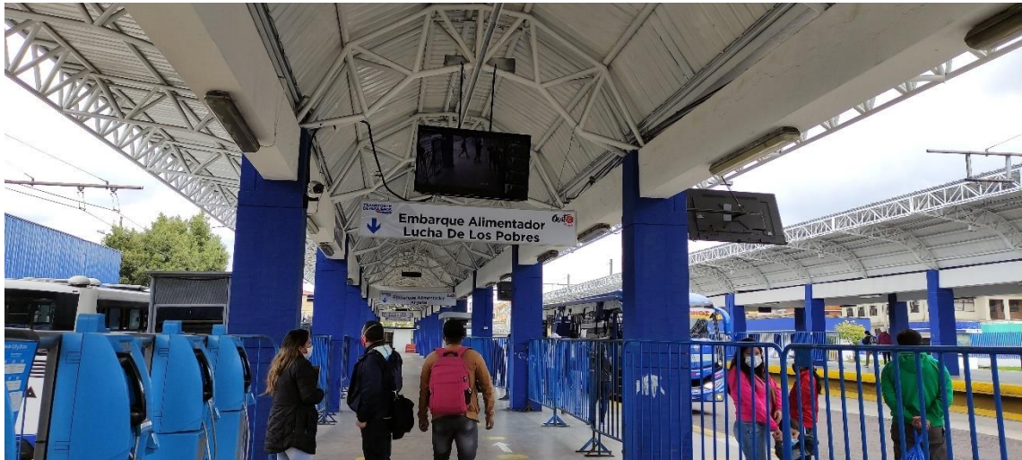
Figura 4-1. Sistemas de información al usuario de la estación el Recreo Fuente: Diana Cofre
