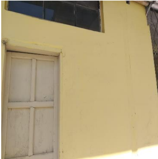
Figura 6-3: Área de lavandería
