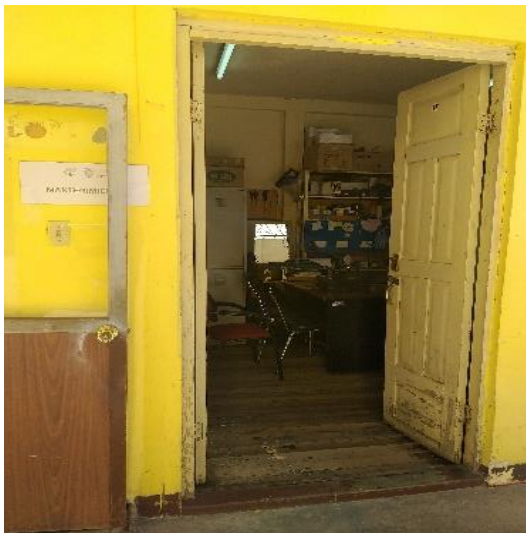
Figura 7-3: Área de mantenimiento
