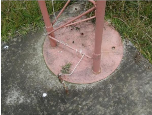
Figura IV.43. Conexión a tierra
