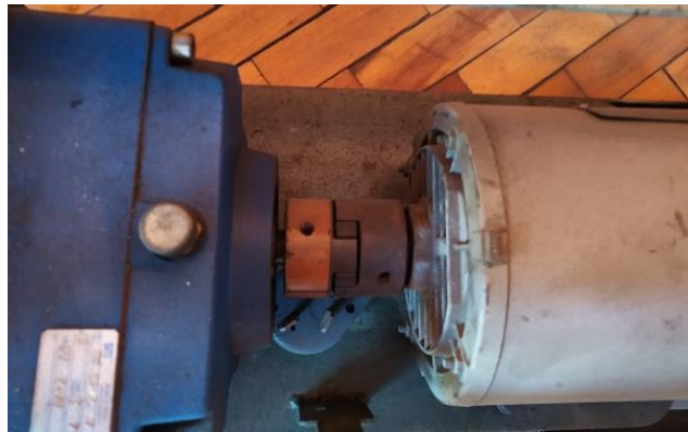
Figura 5-3: Motor y reductor de velocidades
