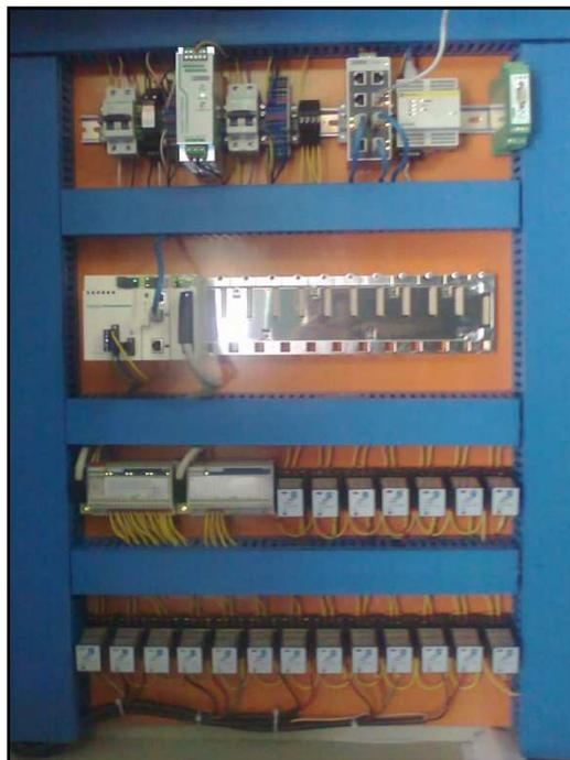
**Figura 89:** Tablero de control implementado
