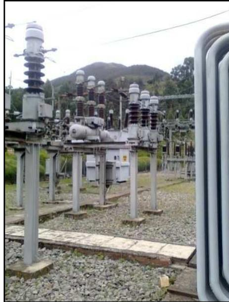
**Figura 90:** Disyuntores y seccionadores (central hidroeléctrica ALAO)
