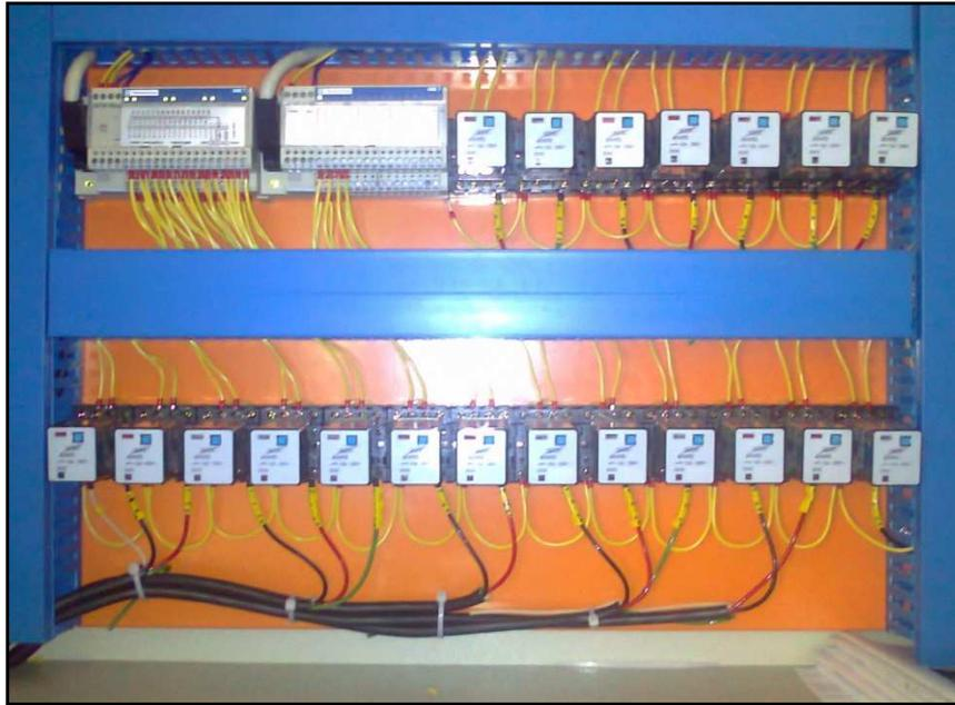
**Figura 98:** Cableado de estados de seccionadores/disyuntores y estados de fallos
