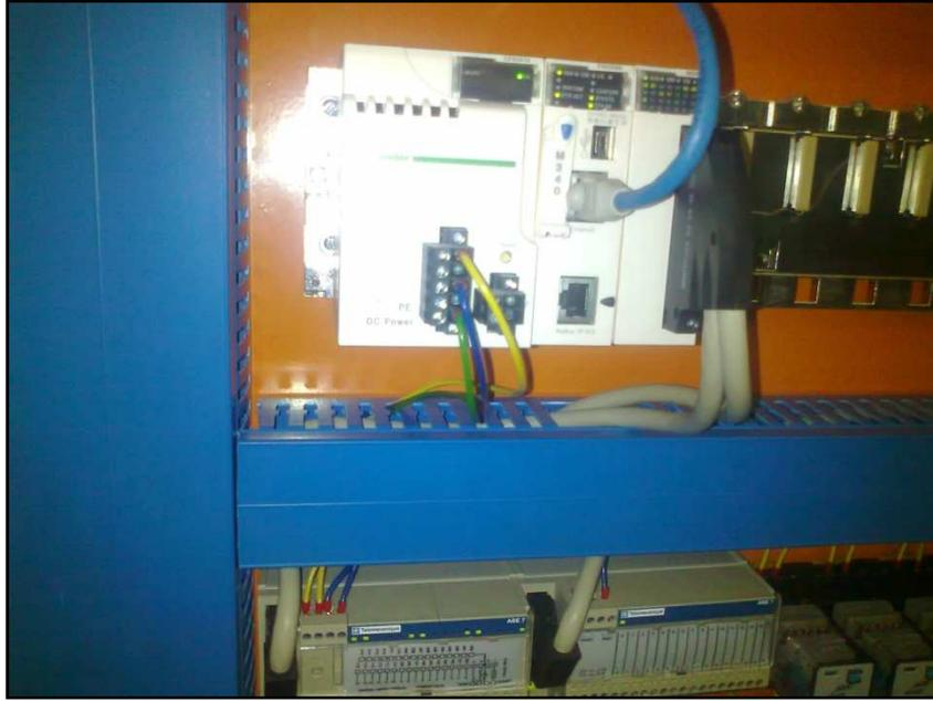
**Figura 100:** Implementación del telefast hacia el PLC
