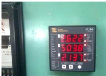
**Figura 81:** Vista frontal del ION 6200 ya instalado
