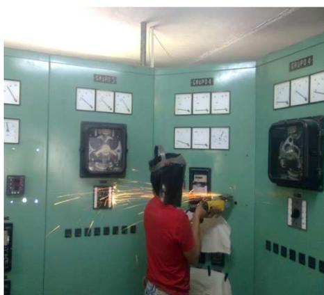
Figura 77: a) Perforación del tablero
