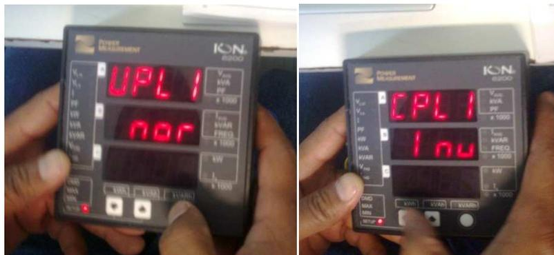
Configuración polaridad fases de voltaje y corriente provenientes de los TT y TI
