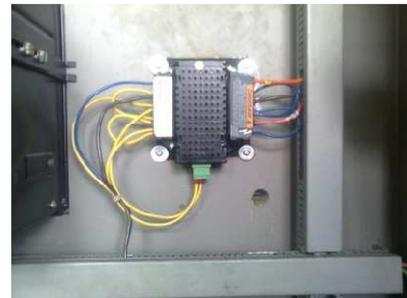
**Figura 80:** a) Instalación del ION 6200    b) Conexión del ION 6200
