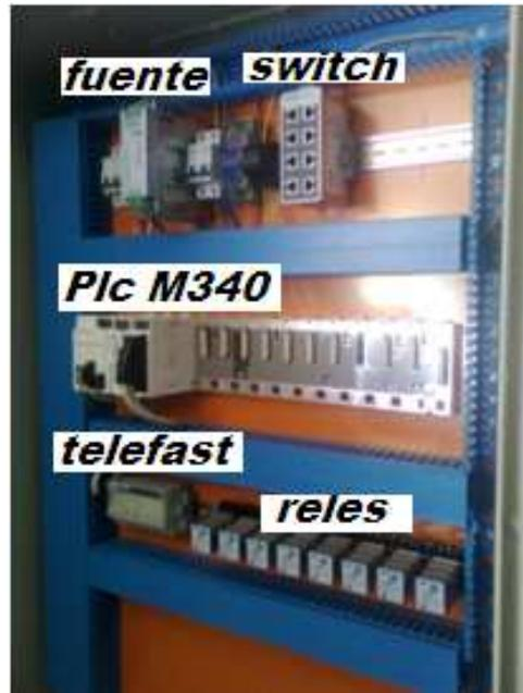
**Figura 82:** Instalación y montaje del tablero de control
