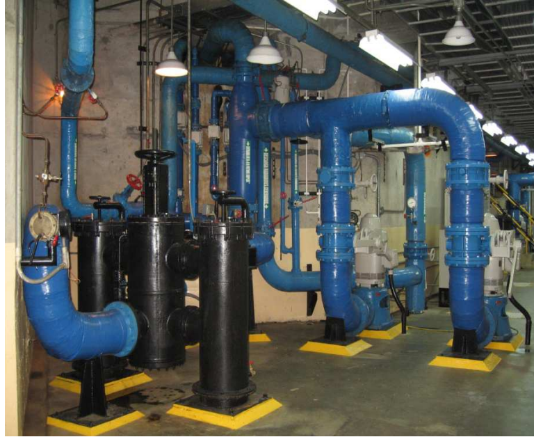
Figura 2.18: Sistema de Agua de Enfriamiento (SAE).
