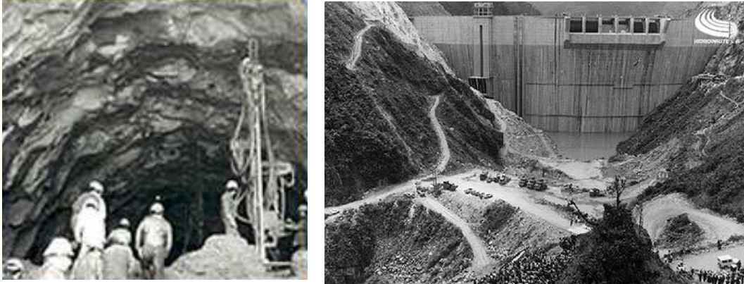
Figura 2.1: Construcción del Proyecto Hidroeléctrico Paute.
