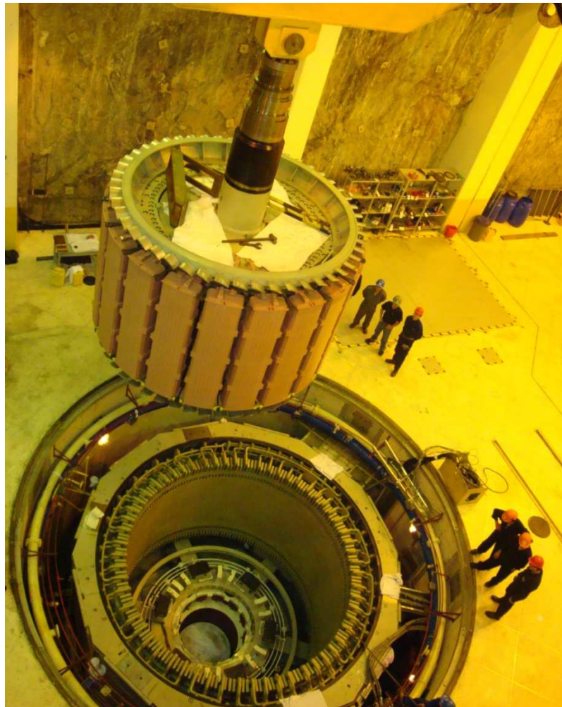
Figura 2.9: Rotor y Estator de las Unidades de Generación.
