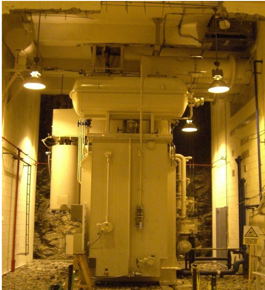
Figura 2.10: Transformador Principal.
