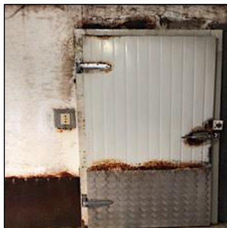
Figura 4-3: Cámara frío de lácteos KASTDALEN.
