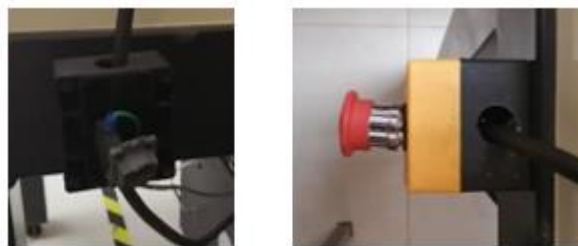
Figura 5-2: Reparación del paro de emergencia
