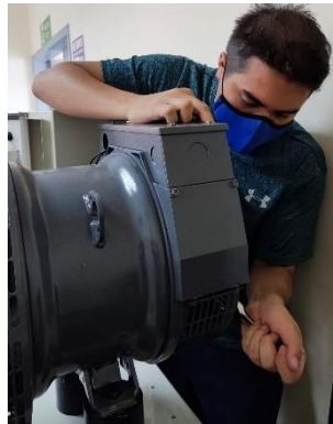
Figura 4-2: Ajuste de la tornillería del generador
