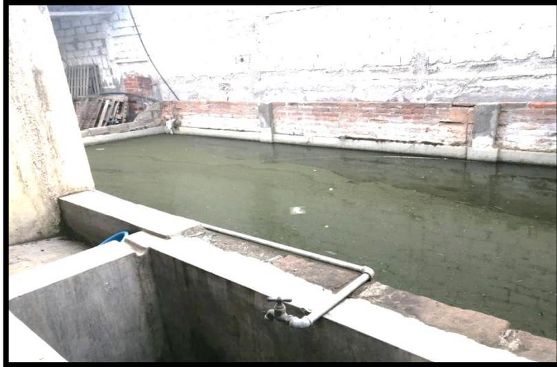
**Figura 5-3:** Tanque sedimentador rectangular
