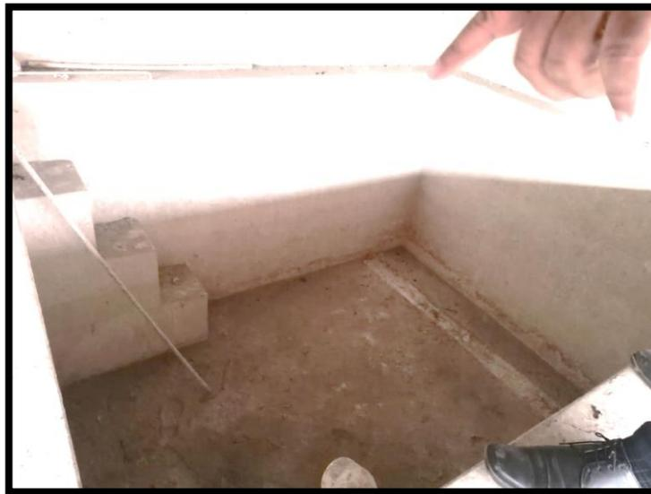
**Figura 4-3:** Tanque de floculación y coagulación
