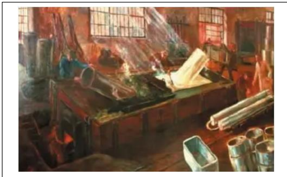
Figura 3-1. Proceso de galvanizado en el siglo XIX.
