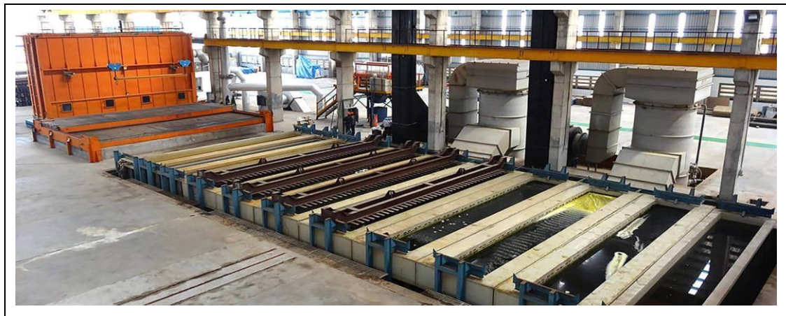
Figura 5-1. Planta de galvanizado moderna.
