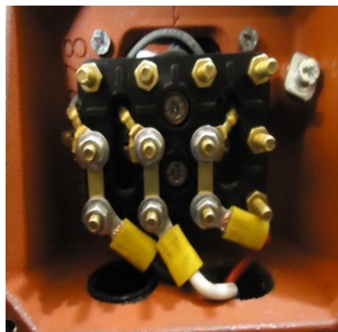
Figura. 4.7: Sistema de mando, potencia. Figura. 4.8: Conexiones del motor.
