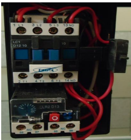
Figura. 4.7: Sistema de mando, potencia. Figura. 4.8: Conexiones del motor.
