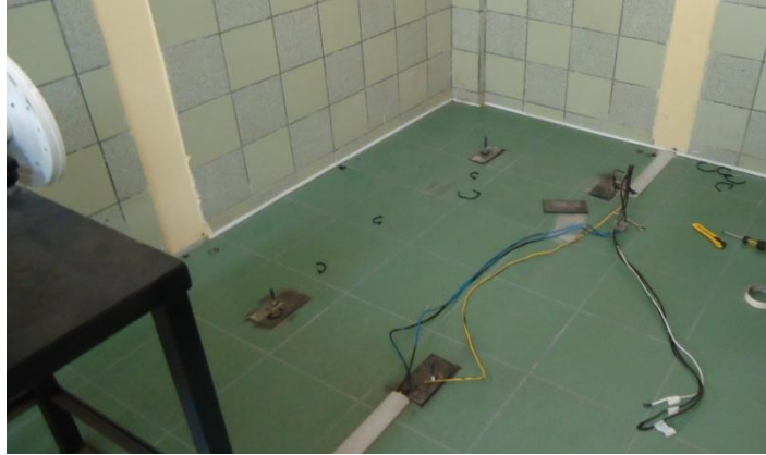
Figura 4.3: Levantamiento del banco de pruebas para su readecuación.
