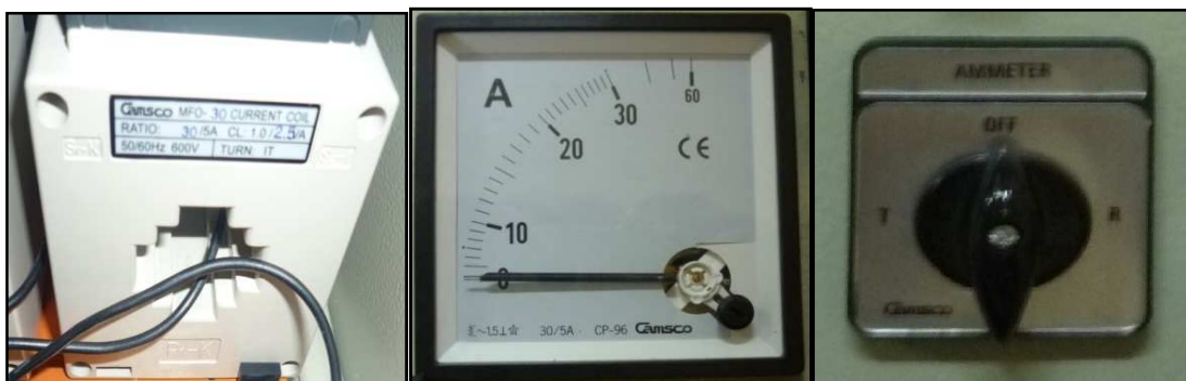
Figura 3.12: Transformador, amperímetro y conmutador
