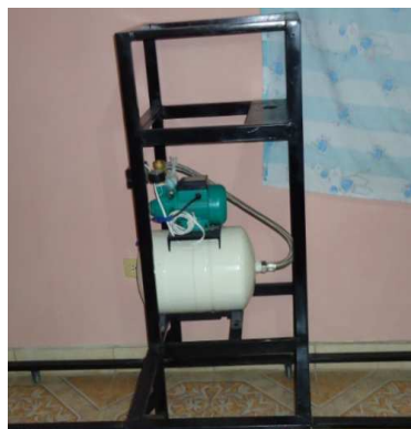
Figura 3.17: Montaje de la bomba B1
