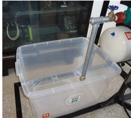
Figura 3.22: Tanque T1 instalado
