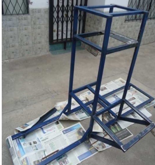
Figura 3.7: Construcción de la estructura
