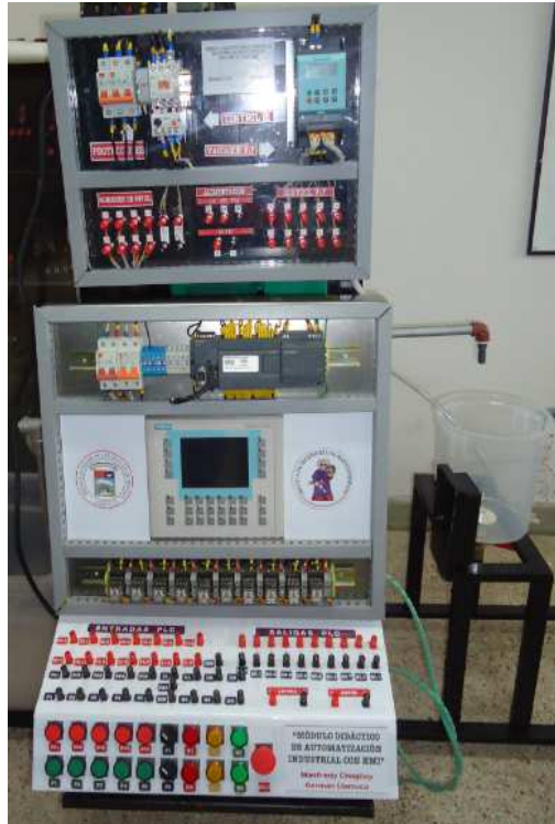
Figura 3.26: Montaje del módulo de automatización
