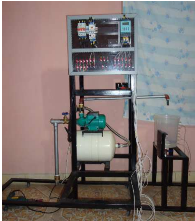
Figura 3.25: Montaje del tablero de control TB1
