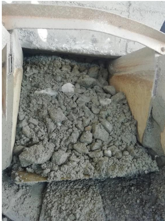
Figura 1-1: Problemas de humedad
