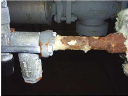
Tubería Oxidada sacada el aislamiento
