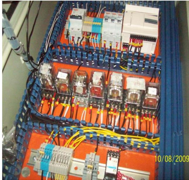
Figura 3.5 M ó d u l o d e c o n t r o l .
