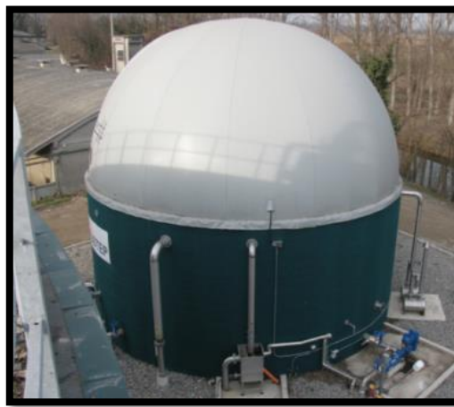
Figura 5-2: Sistema de cubierta flexible
