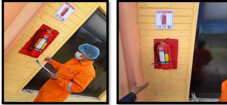
**Figura 4-3:** inspección extintores
