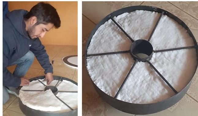
**Figura 15-4:** Montaje de manta fibra cerámica en el interior de la tapa
