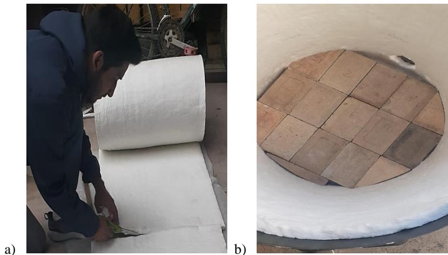
**Figura 8-4:** a) Corte de manta cerámica para el interior del cuerpo, b) Base de ladrillos
