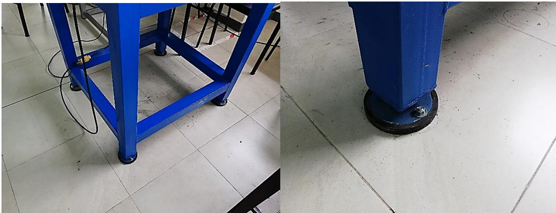
Figura 30-3: Anclaje del banco de pruebas
