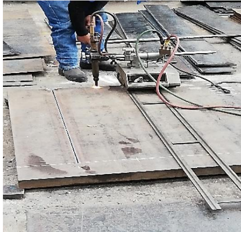
Figura 22-3: Corte de la plancha de acero
