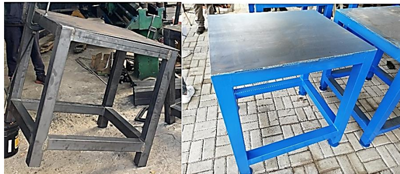
Figura 16-3: Construcción de la mesa del módulo de simulación
