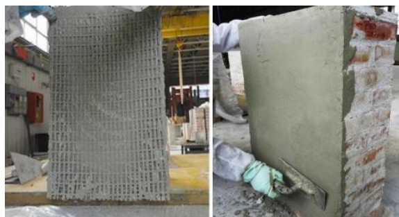
Figura 17-1: Colocación del FRCM
