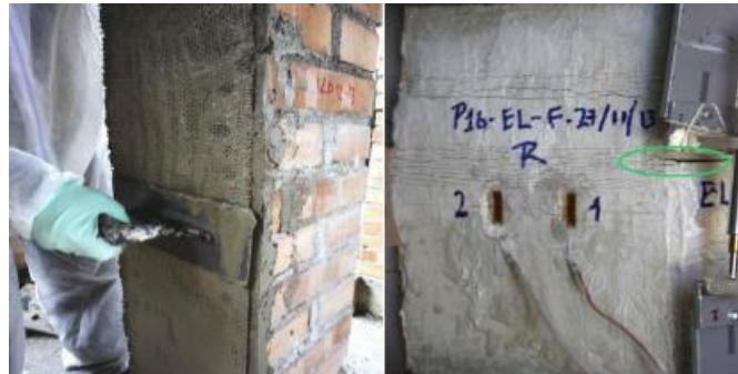
Figura 18-1: Muros reforzados de lino y PBO
