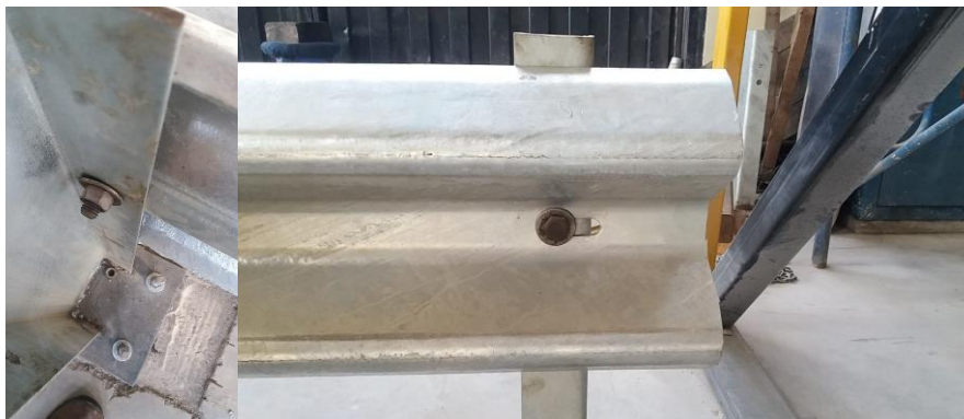
Figura 112-3. Perfil w y poste ensamblado
