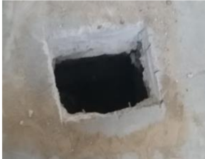
Figura 99-3. Perforación de 65cm para instalar los soportes.
