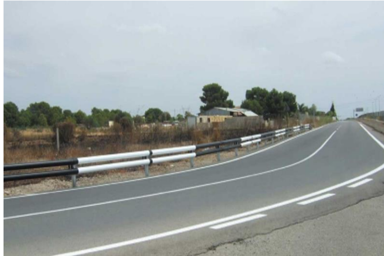
Figura 4-2. Baranda de seguridad de viga tubular
