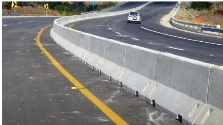
Figura 3-2. Baranda de seguridad de hormigón tipo “New Jersey”
