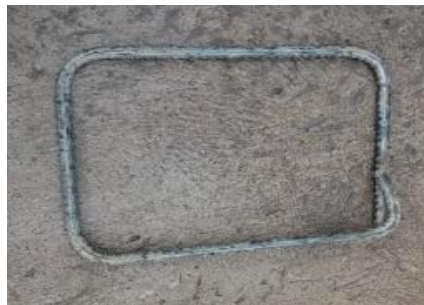
Figura 100-3. Estribos para instalar las cuatro varillas roscadas
