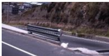
Figura 44-3. Guardavía utilizado en las carreteras de Ecuador
