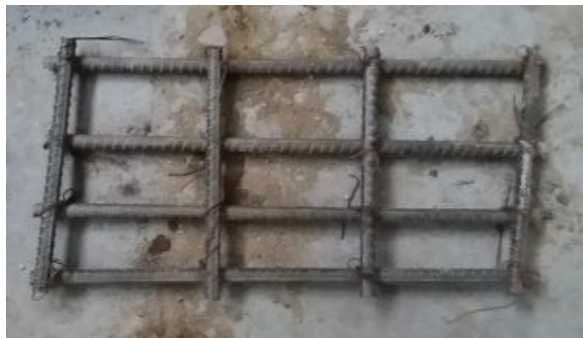
Figura 102-3. Parrilla colocada en la perforación para soporte de la zapata.
