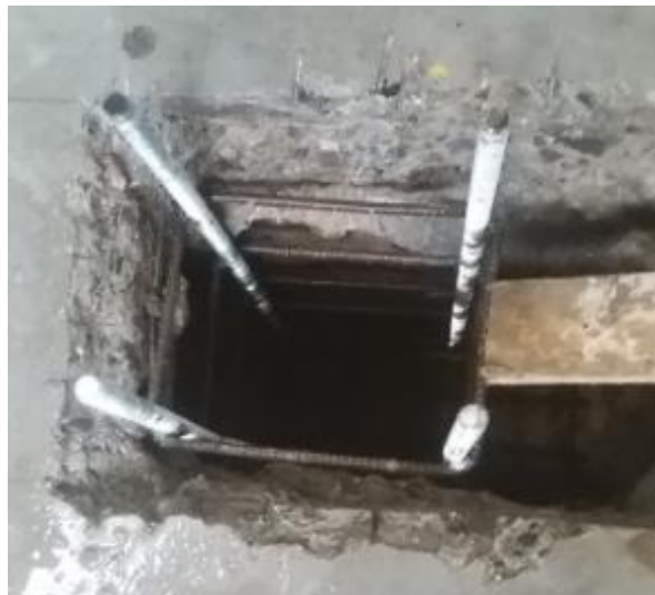
Figura 103-3. Soporte dentro de la perforación.
