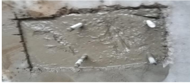
Figura 104-3. Soporte totalmente fijado con una varilla roscada sobresaliendo de 8cm.
