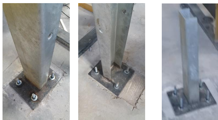
Figura 111-3. Placa completamente anclada a la porta probetas
