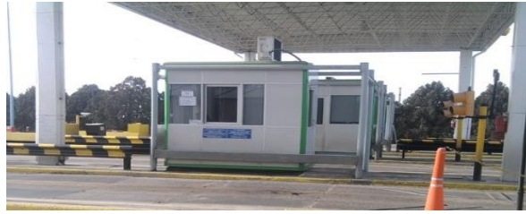
Figura 8-1: Casetas de cobro.
