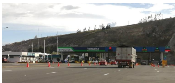
Figura 4-1: Acceso a la estación de peaje.
