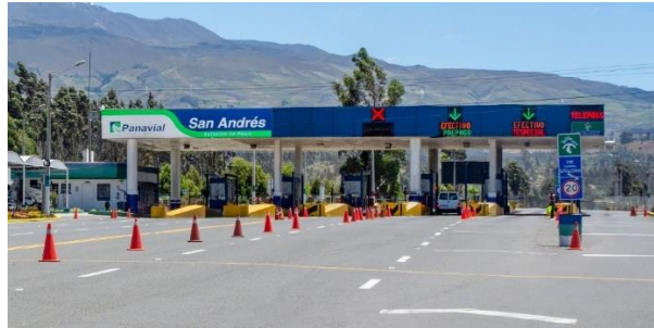
Figura 2-1: Estación de peaje.
