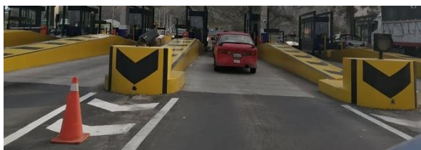
Figura 7-1: Muros de protección.
