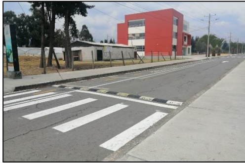
Costado lateral derecho del Edificio Nuevo de la Facultad de Ciencias Pecuarias.
