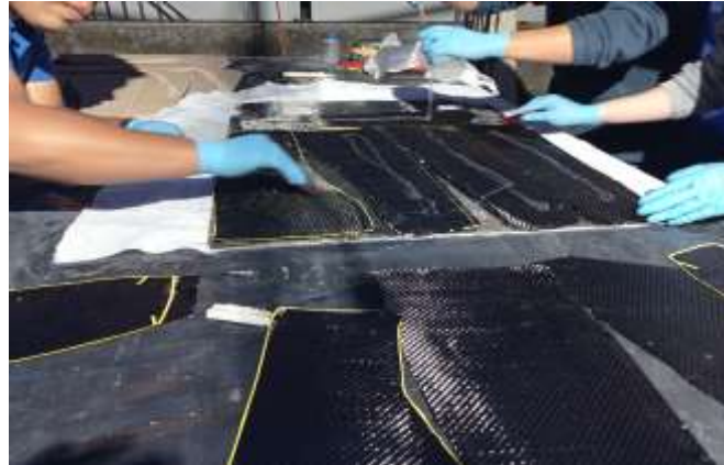
Figura 42-3. Aplicación de la mezcla de resina epoxi y catalizador
