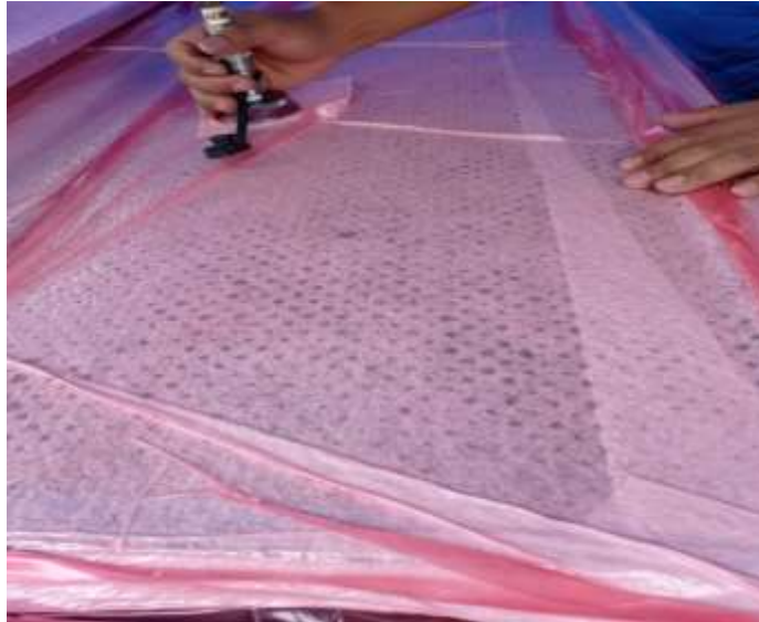
Figura 38-3. Aplicación de plástico sobre la fibra de carbono.
