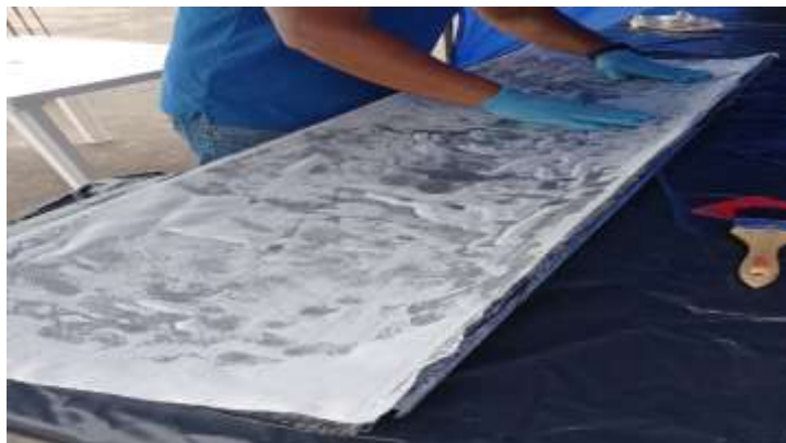
Figura 37-3. Aplicación de plástico sobre la fibra de carbono.
