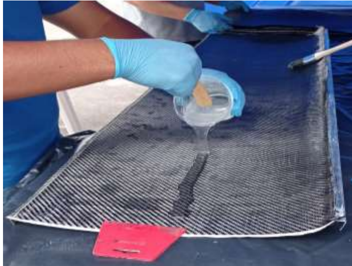
Figura 36-3. Nueva aplicación de mezcla y fibra de carbono
