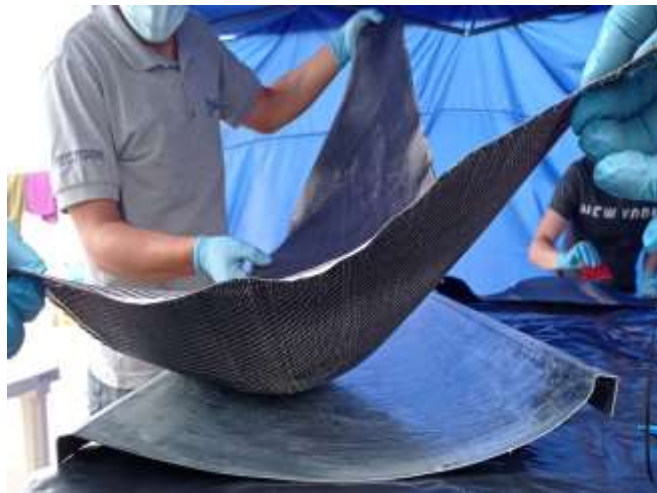
Figura 35-3. Aplicación de la fibra sobre las superficies
