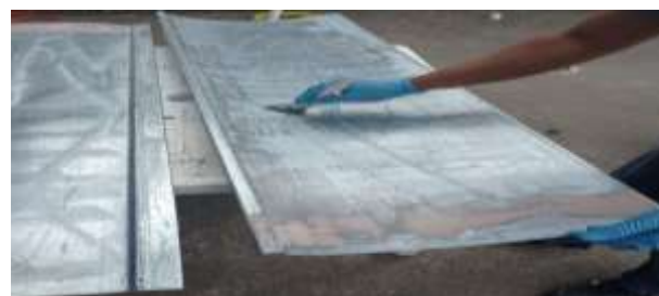
Figura 31-3. Cera desmoldante y aplicación
