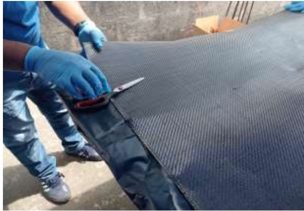
Figura 32-3. Corte de fibra de carbono
