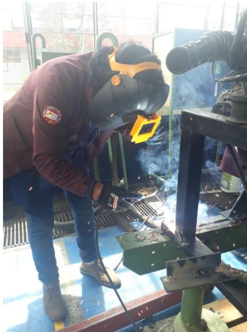
Figura 7-3. Soldadura de tipo electrodo a bases del motor
