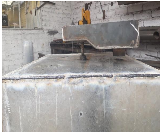
Figura 14-2: Instalación del embudo giratorio en el contenedor
