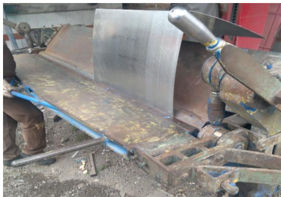
Figura 9-2: Corte y doblado de lámina de acero
