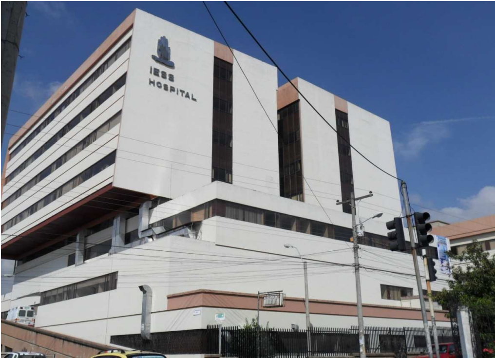
FOTOGRAFIA Nº 1. HOSPITAL DEL INSTITUTO ECUATORIANO DE SEGURIDAD SOCIAL RIOBAMBA.
