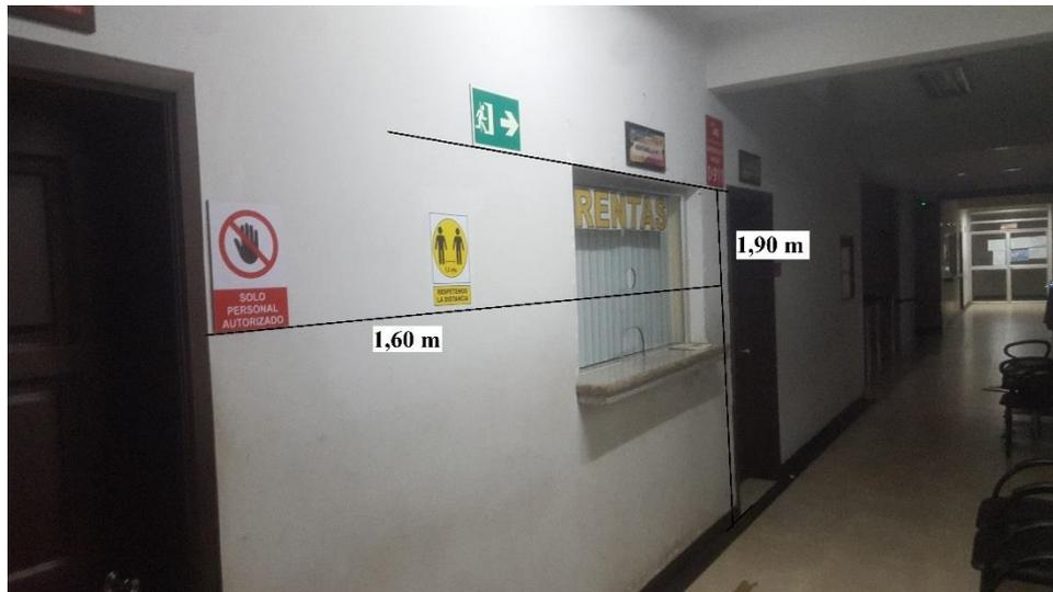
**Figura 1-4:** Señalética de prohibición, advertencia, vía de evacuación y ECU 911. Según NTE INEN 2239.
