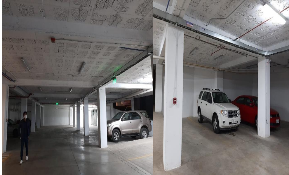
Figura 7-3: Sub suelo parqueaderos.
