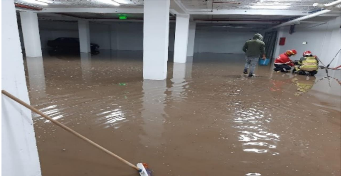
Figura 8-3: Inundación en el Sub suelo en los parqueaderos.
