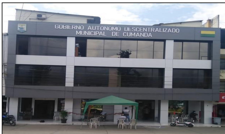
Figura 2-3. Instalaciones del GADM de Cumandá
