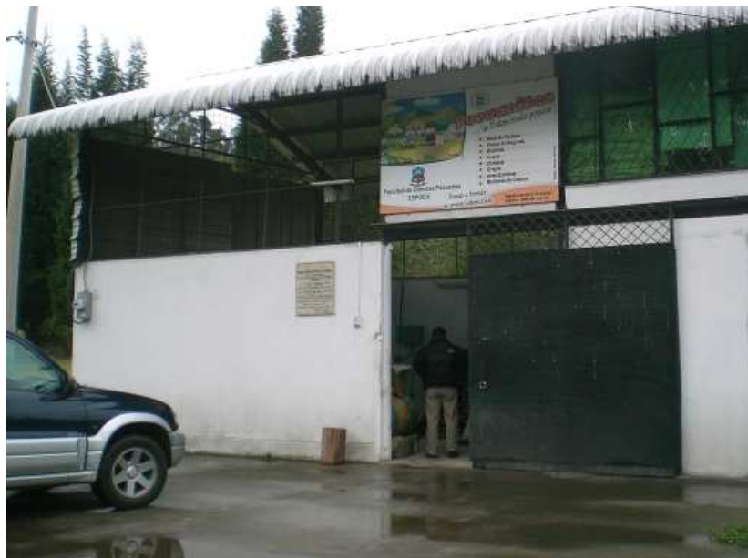
Fotografía 2. . Patio o zona de parqueadero.
