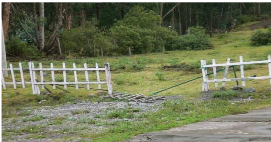
Fotografía 3. Cerramiento de la planta.
