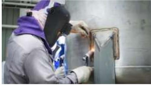
**Figura 7-2:** Arco eléctrico proceso GTAW gas de protección Argón
