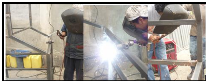
Figura 4.7: Unión de tubos por suelda de arco eléctrico.
