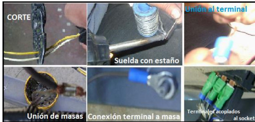
Figura 3.2: Ensamble de cableado a sus terminales.
