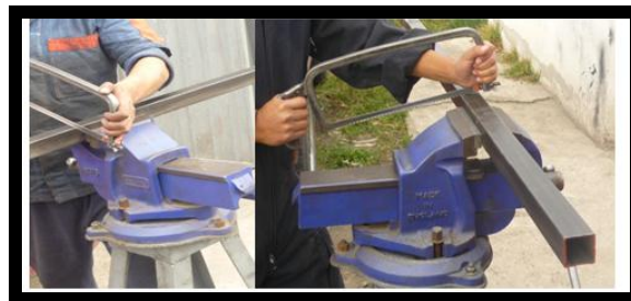
Figura 4.6: Medición y corte de tubos.
